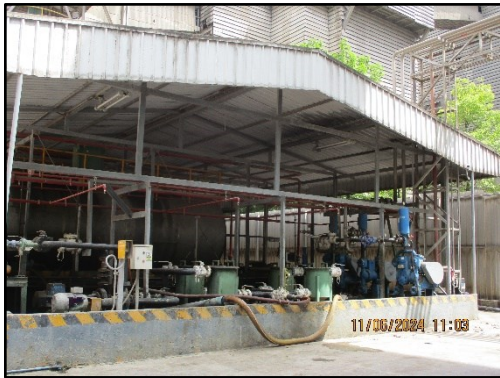
ภาพที่ 2.15 คันคอนกรีต (Bund Wall) รอบถังกักเก็บของเสียที่เป็นของเหลว
