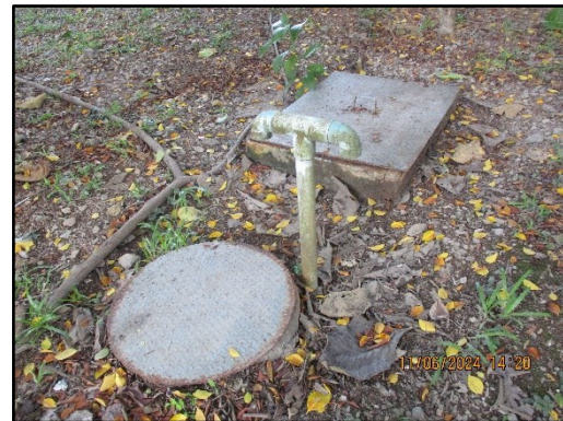
ภาพที่ 2.9 ระบบบำบัดน้ำเสียสำเร็จรูปแบบ Septic Anaerobic Filter ของโครงการ
