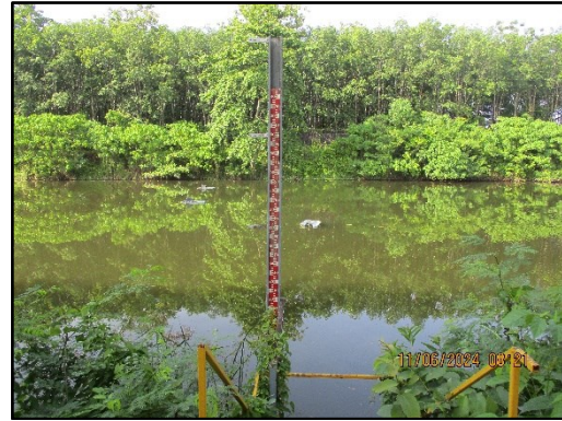
ภาพที่ 2.8 สระน้ำขนาด 200,000 ลูกบาศก์เมตรและมาตรวัดระดับน้ำ
