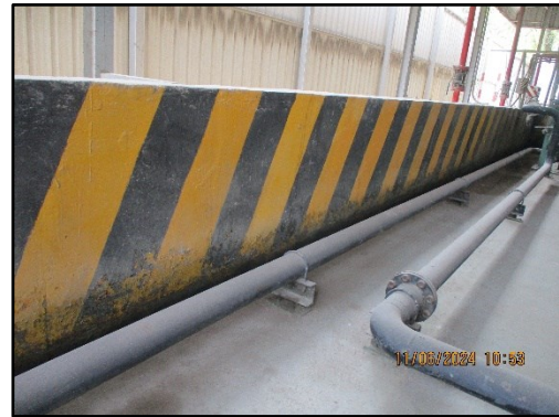
ภาพที่ 2.15 คันคอนกรีต (Bund Wall) รอบถังกักเก็บของเสียที่เป็นของเหลว
